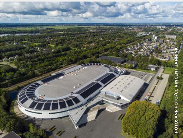
ONDANKS DE ZONNEPANELEN OP HET DAK VAN THIAFV VERKEERT HET IJSSTADION, NET ALS VELE ANDERE IJSBANEN IN NEDERLAND, IN ZWAAR WEER DOOR DE TORENHOGE ENERGIEKOSTEN.
